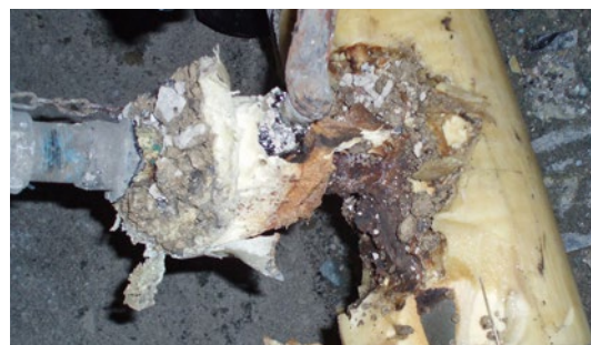
Undichte Fernwärmearmatur
