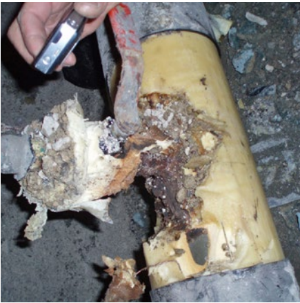
Undichte Armatur
